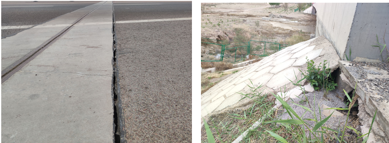
图 3-11 下行线 0 号台伸缩缝锚固区与路面间缝隙及锥护坡顶部空洞
