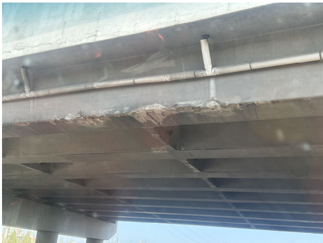
图 3-3 梁底剥落、掉角
