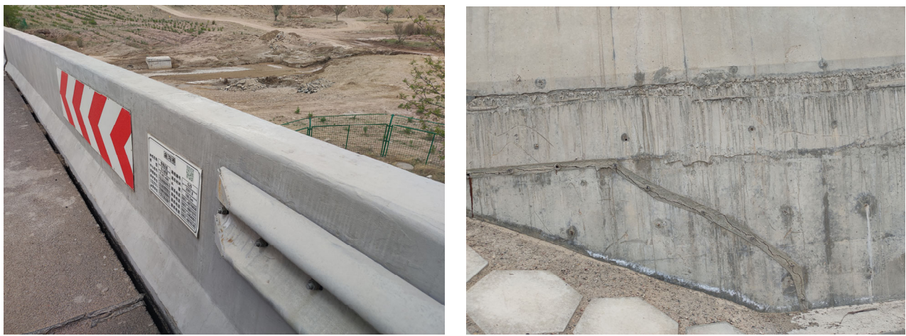
图 3-10 下行线 5 号台侧墙上防撞墙与路面之间缝隙及侧墙斜向裂缝
