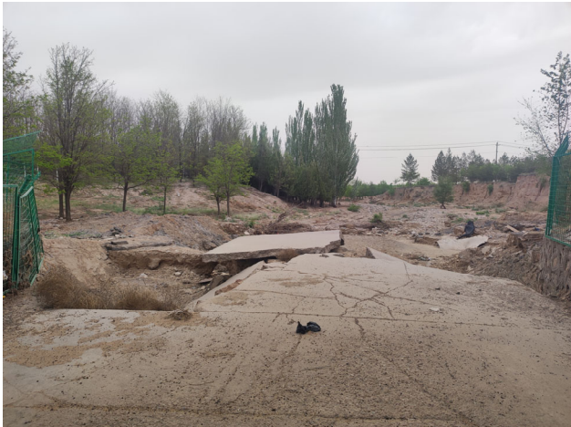
图 3-6 桥下外侧混凝土铺砌水毁
