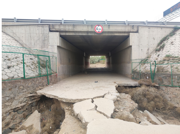
图 3-6 桥下外侧混凝土铺砌水毁
