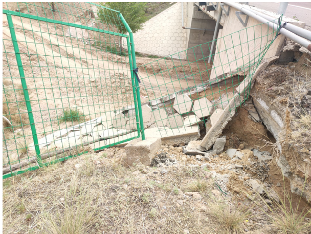
图 3-7 实心六棱砖锥护坡局部塌陷、破损
