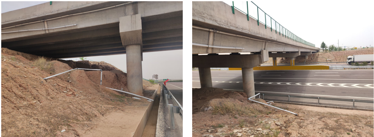
图 3-12 高沙窝西互通立交集中排水设施局部损坏
