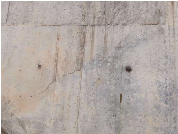
图 3-4 台帽、台身、侧墙裂缝
