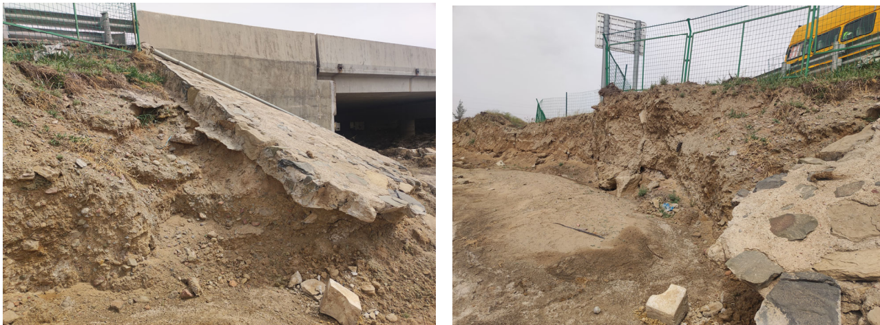
图 3-8 浆砌片石锥护坡局部塌陷、破损
