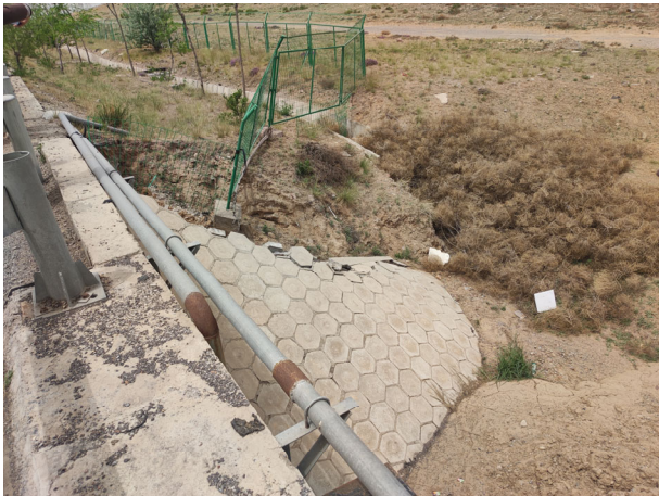
图 3-7 实心六棱砖锥护坡局部塌陷、破损
