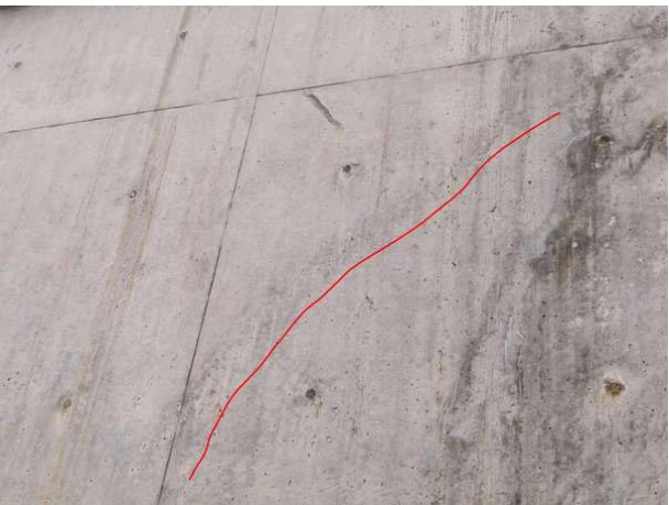
图 3-4 台帽、台身、侧墙裂缝
