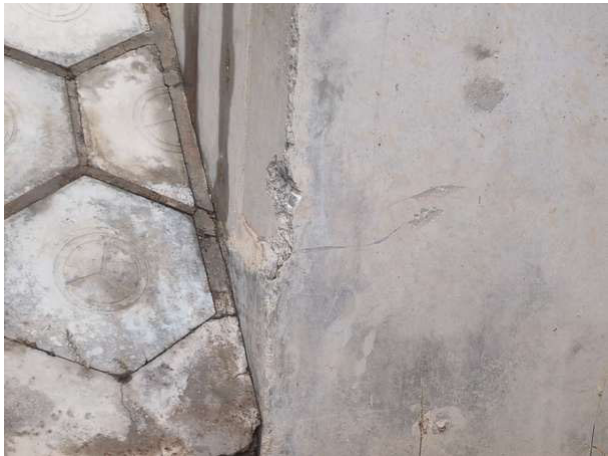
图 3-5 桥台混凝土表面缺陷
