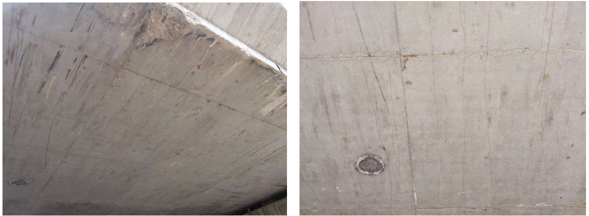
图 3-2 现浇板板底横向裂缝
