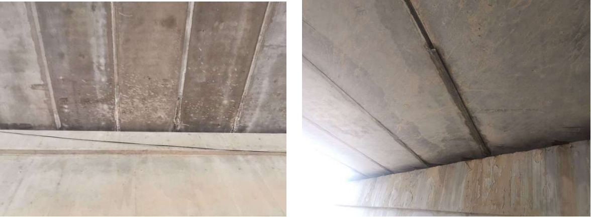
图 3-1 空心板部分铰缝勾缝脱落、渗水析白
