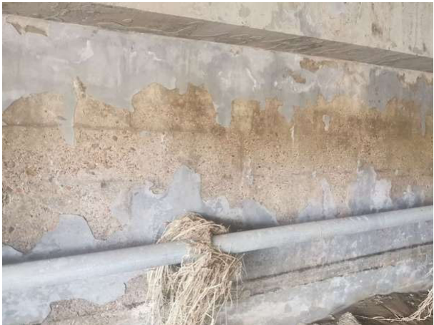
图 3-5 桥台混凝土表面缺陷
