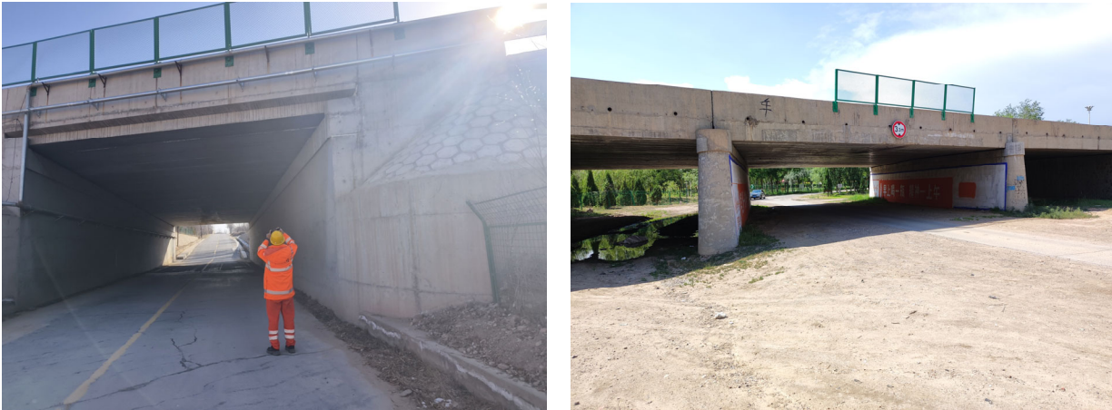
图 3-1 石坝桥右桥和三道沟桥缺少集中排水管
