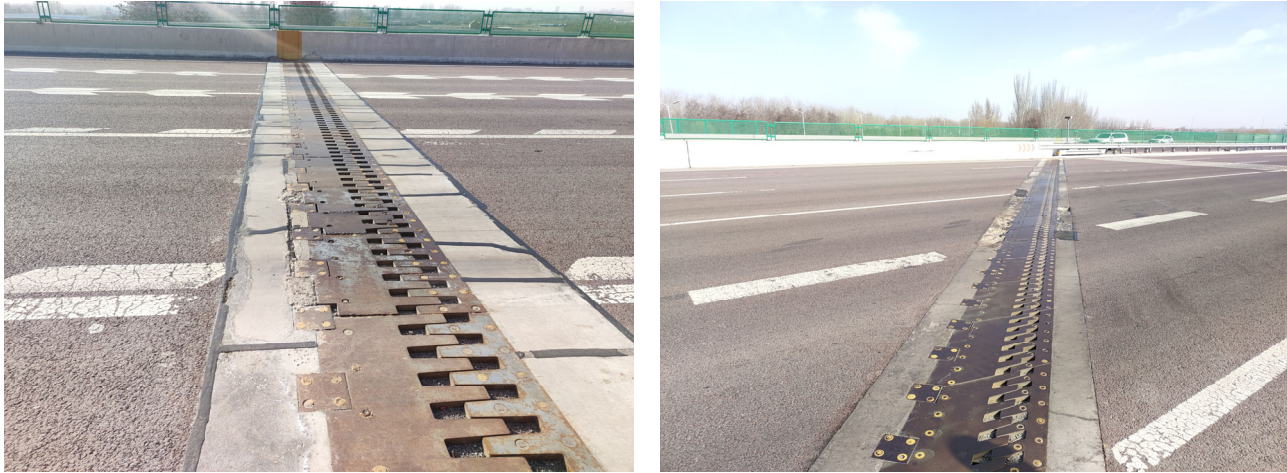
图 3-1 永宁黄河桥连接线分离立交桥及杭家庄桥伸缩装置病害现状
